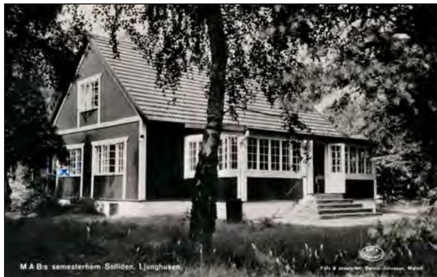
Solliden på Sollidenvägen.
