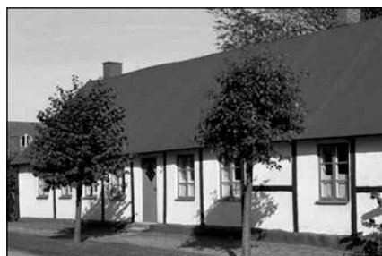
Dykerigården på Dykerigatan.
