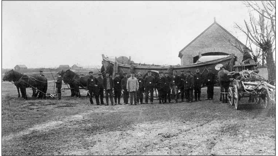
Livräddningsstationen i Skanör vid nuvarande brandstationen.
