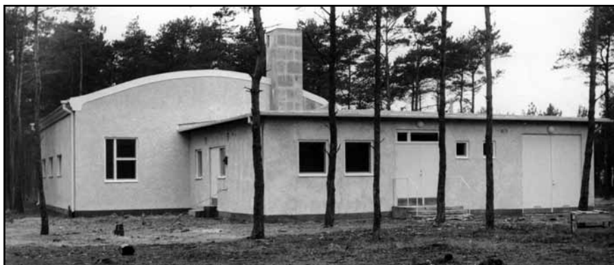
Den nya telefonstationen i Höllviken under byggnad dec. 1954. Foto: Sydsvenskan/Bilder i Syd.
