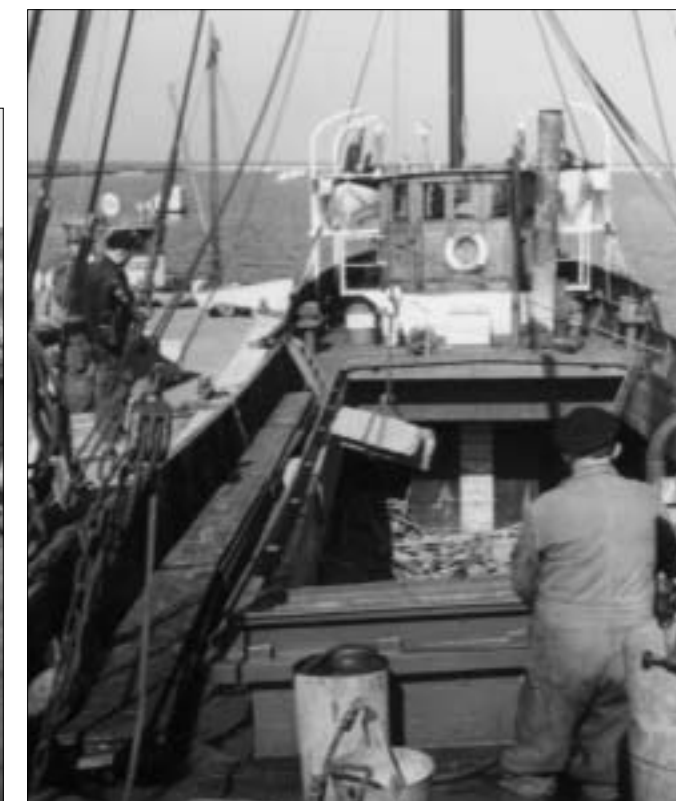
Granit från Bohuslän till vägbygget lossas i Falsterbokanalen. Observera Esso Marin i, Esso-Bengtssons bunkringsbåt i bakgrunden.
